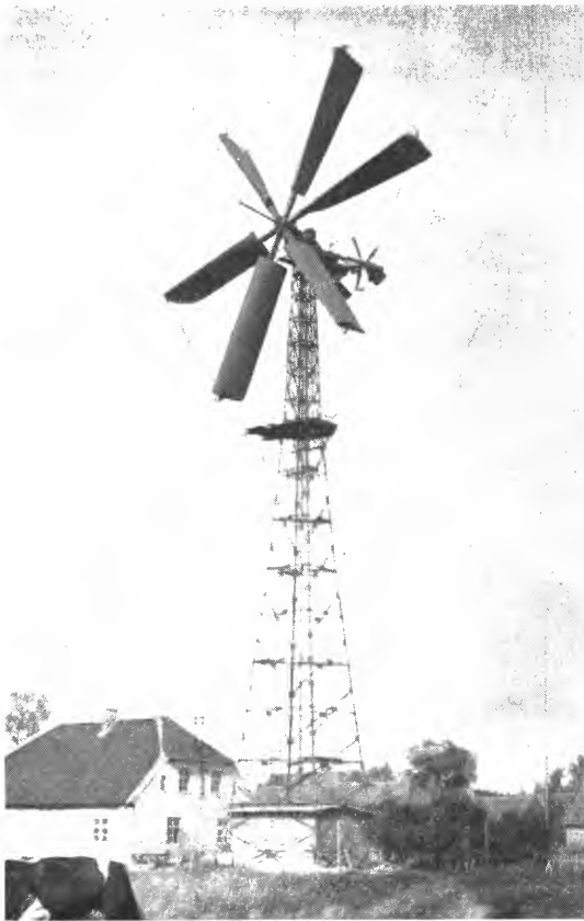
Fig. 3. Større tysk vindkraftanlegg. Vingediameter 20 m, mastehøide 35 m. Ca. 120 HK.
