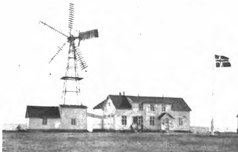
Fig. 1. Norsk vindkraftanlegg. Dverbergs lysverk på Andøya, bygget av Ulrik Dahle. Ca. 10 HK.
