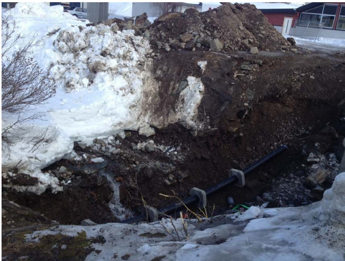
Figur 16. I april 2012 ble det gravd ledningsnett i Båtsfjord. Det var da svært liten vannføring i mange av ytre Finnmarks elver. Bildet viser grøftegata som går tvers gjennom Skoleelva. Bekken som renner i senter av bildet er Skoleelva. Elva er så å si tørrlagt. Bilde fra Arnt Albertsen.
