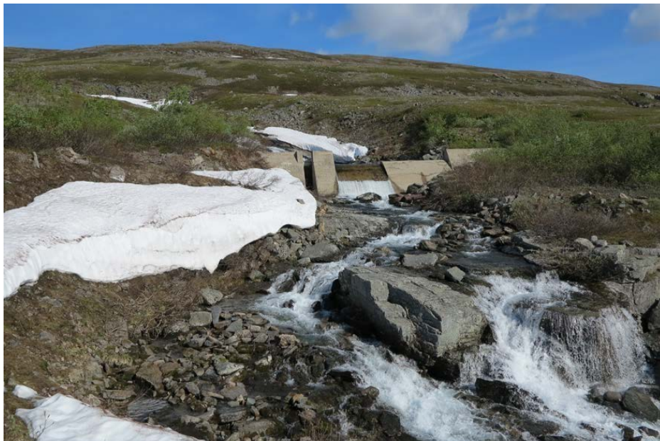
Figur 5. Demningen i Neptunelva sett nedenfra.
