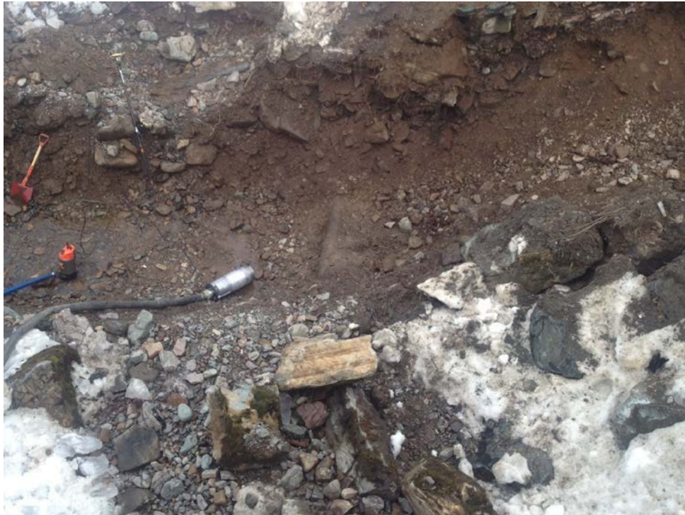
Figur 15. I april 2012 ble det gravd ledningsnett i Båtsfjord. Det var da svært liten vannføring i mange av ytre Finnmarks elver. Bildet viser grøftegata som går tvers gjennom Neptunelva. Spaden og pumpene er plassert på det i senter av elva. Elva er så å si tørrlagt. Bilde fra Arnt Albertsen.
