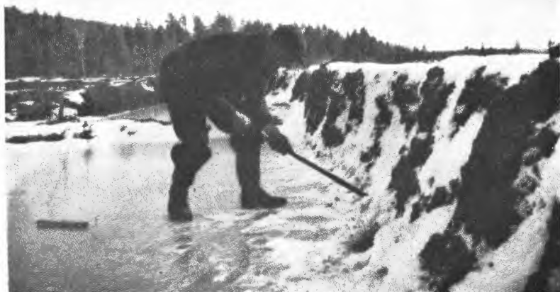
Fig. 4. Ladingen foretas. Patronene settes inn på skrå ned fra iskantene.
