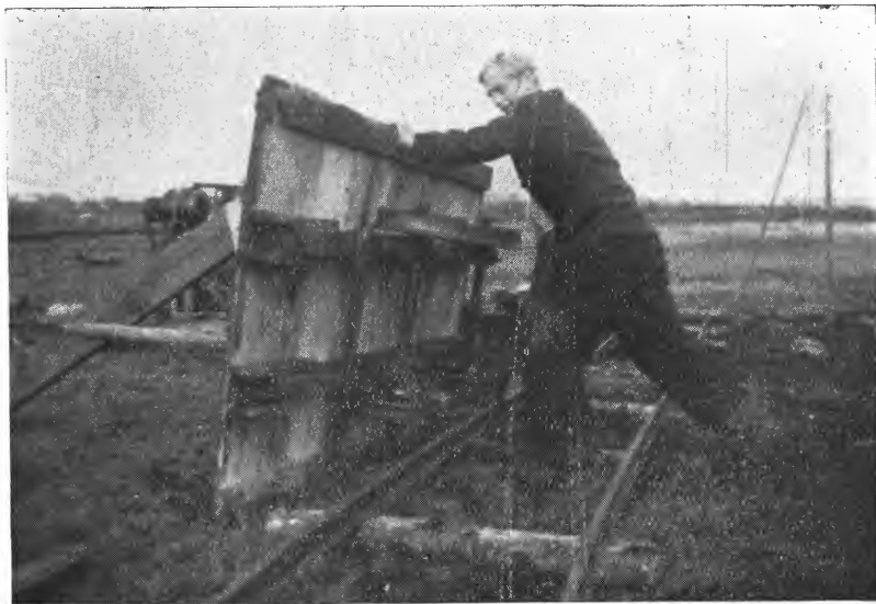
Fig. 3. Fra Knudmose ved Herning. Enkel skinnegang til tørkefeltet. Trallen vippes til side ved forbi kjøring.
