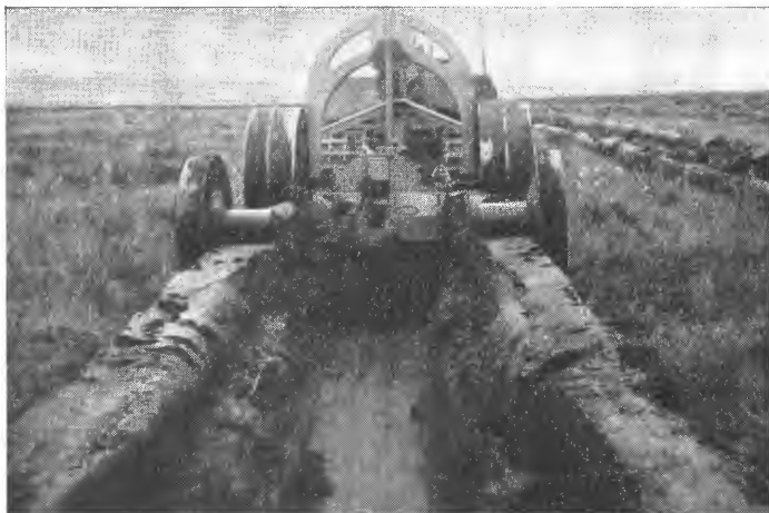
Fig. 6. Fra Carnwath moss, Skottland. Cuthbertson's grøfteplog for skolplantefelter i arbeid. Det legges opp en velt på begge sider av grøfta. Senere plantes på veltene.
