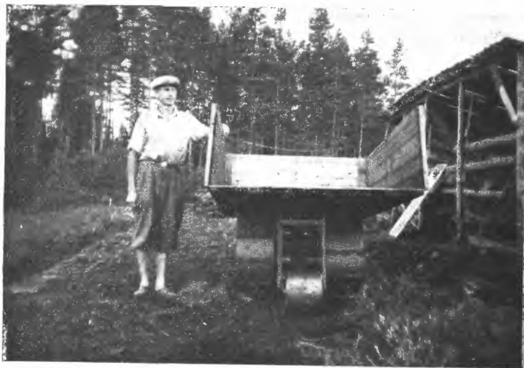
Fig. 3. Bildet viser transportvogna etter at den er utstyrt med stålplatehjul i stedet for gummi-hjul. (Fot. Aa. L.)
