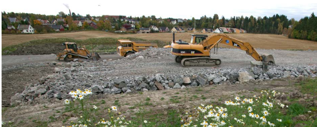
Figur 9: Veibygging på jordbruksareal ved Kvakkestad i Østfold. Foto: Oskar Puschmann
