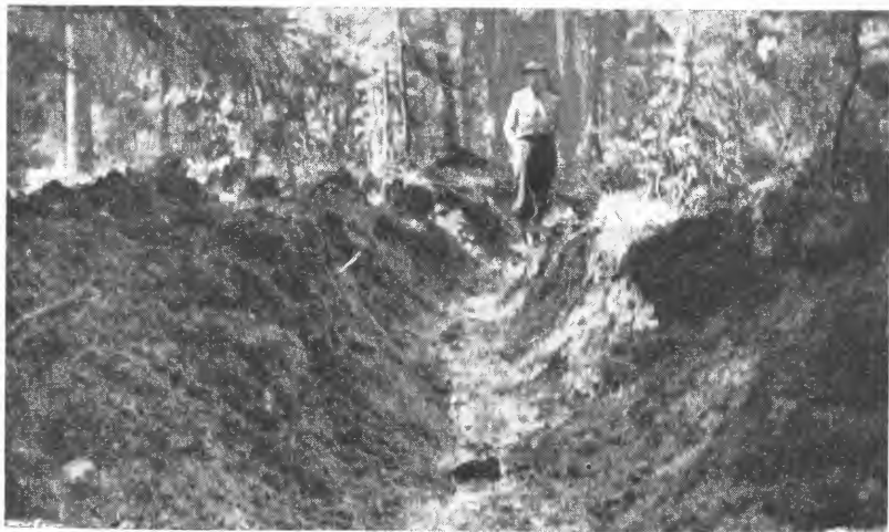
Sprengt skogsgrøft etter utført rensk.
