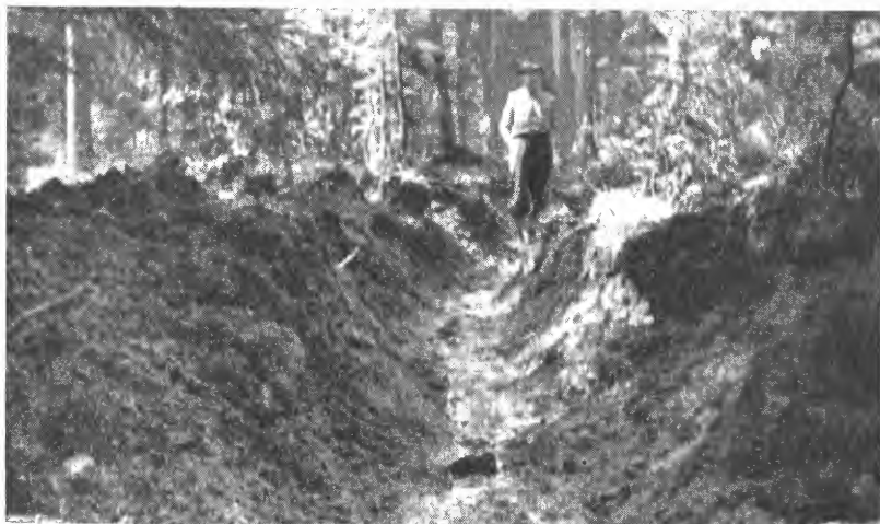
Sprengt skogsgrøft etter utført rensk.
