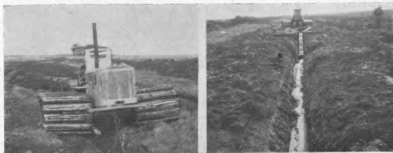
Fig. 3. Fra «Hirvineva storodlingsforetak» ved Oulu. Til venstre en av beltetraktorene som trakk grøfteplogen (merk treklampene på beltene). Til høyre ser en grøfteplogen i arbeid.
