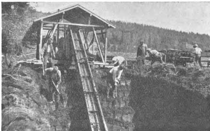
Maskintorvdrift på Gårdsmyra, Våler i Solør. Torven trilles her utover tørkefeltet. (Fot. J. G. T.)
