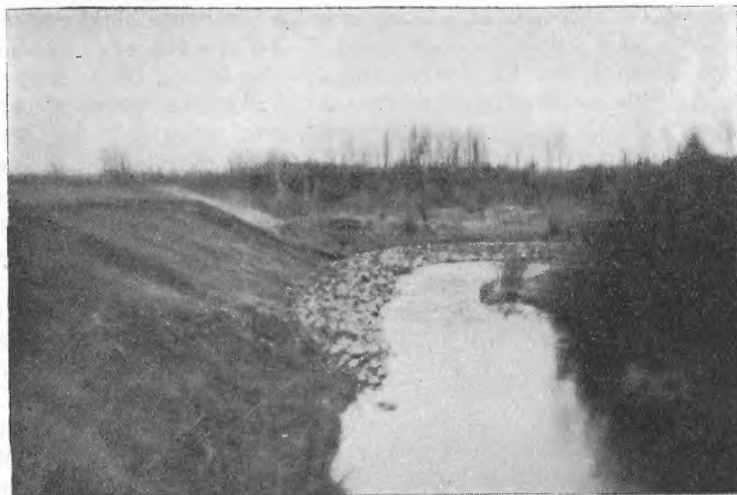
Fra Ogomaw County, Michigan. Forbygning i elvesiden, Rifle River. Skråningene over muren er tilsådd med svingel- og raigrasarter. (24/4—51).
