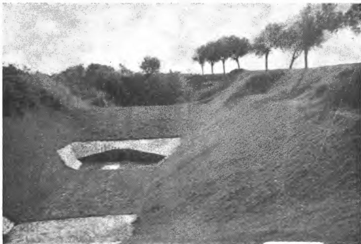
Fra Engelmansbrunn dreneringsanlegg og flomkontrollsystem. Flombassenget på bildet, som er det øverste i systemet, rommer ca. 1500 m 3 . Avløpet gjennom dammen som sees på bildet, reduserer flomvannføringen, og dette — sammen med liknende anlegg lenger nede i vassdraget — gjør at flomskader unngås. (Fot. Aa. L.).
