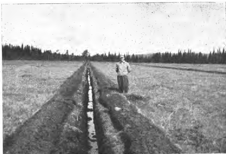
Fra Hjelummyra, Furnes amnening. Grøfting med Vikeidplogen den 1. september 1959.
