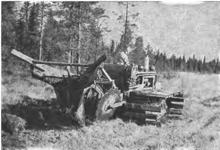
Vikeidplogen i arbeid på Hjellummyra, Furnes almenning. Plogen er montert på traktorens hydraulikk. (Fot. Aa. L.)
