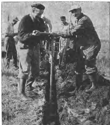
Med en «grøfttekrok» dreies passe lange bordbiter («tverrliggere») inn i grøftesidene i bestemt avstand fra bunnen av grøfta. (Fot. LFB.)
