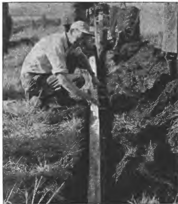
Bord eller bakhun legges ned på «tverrliggerne». (Fot. LFB.)
