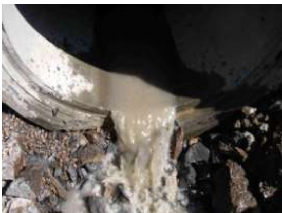
Figur 10. Avrenning fra massedeponiet på Lorangmyr. I mai 2006 (bilde) var det partikler i vannet, men etter omlegging av bekk som rant gjennom deponiet ble forholdene bedre.
