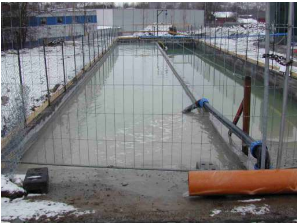
Figur 11. Plastøpt sedimentasjonsbasseng på Wøyen med to kammer for alternerende drift.
