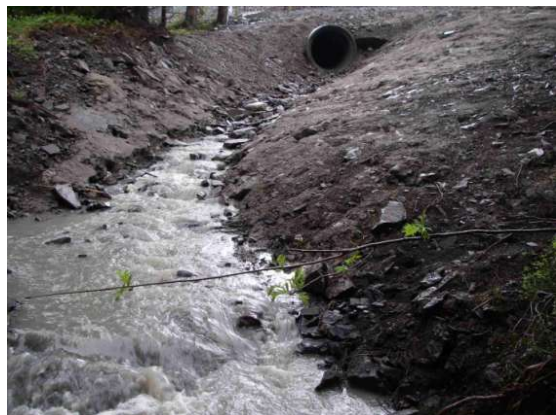
Figur 10. Avrenning fra massedeponiet på Lorangmyr. I mai 2006 (bilde) var det partikler i vannet, men etter omlegging av bekk som rant gjennom deponiet ble forholdene bedre.
