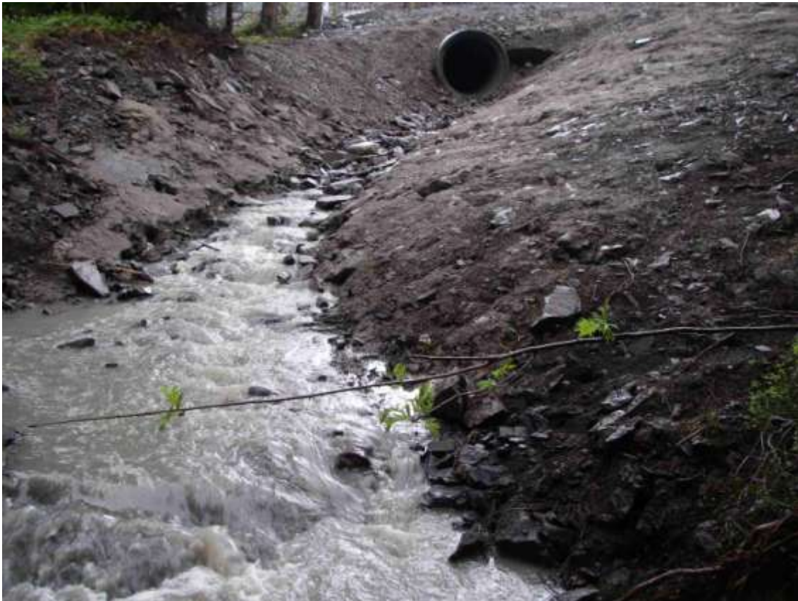
Figur 23. Kulvert og avrenning nedstrøms utløp fra massedepoiet på Lorangmyr. Fra mai 2006 hvor avrenningen var blakket med jordpartikler. Senere vannprøver har vist lavt innhold av partikler.
