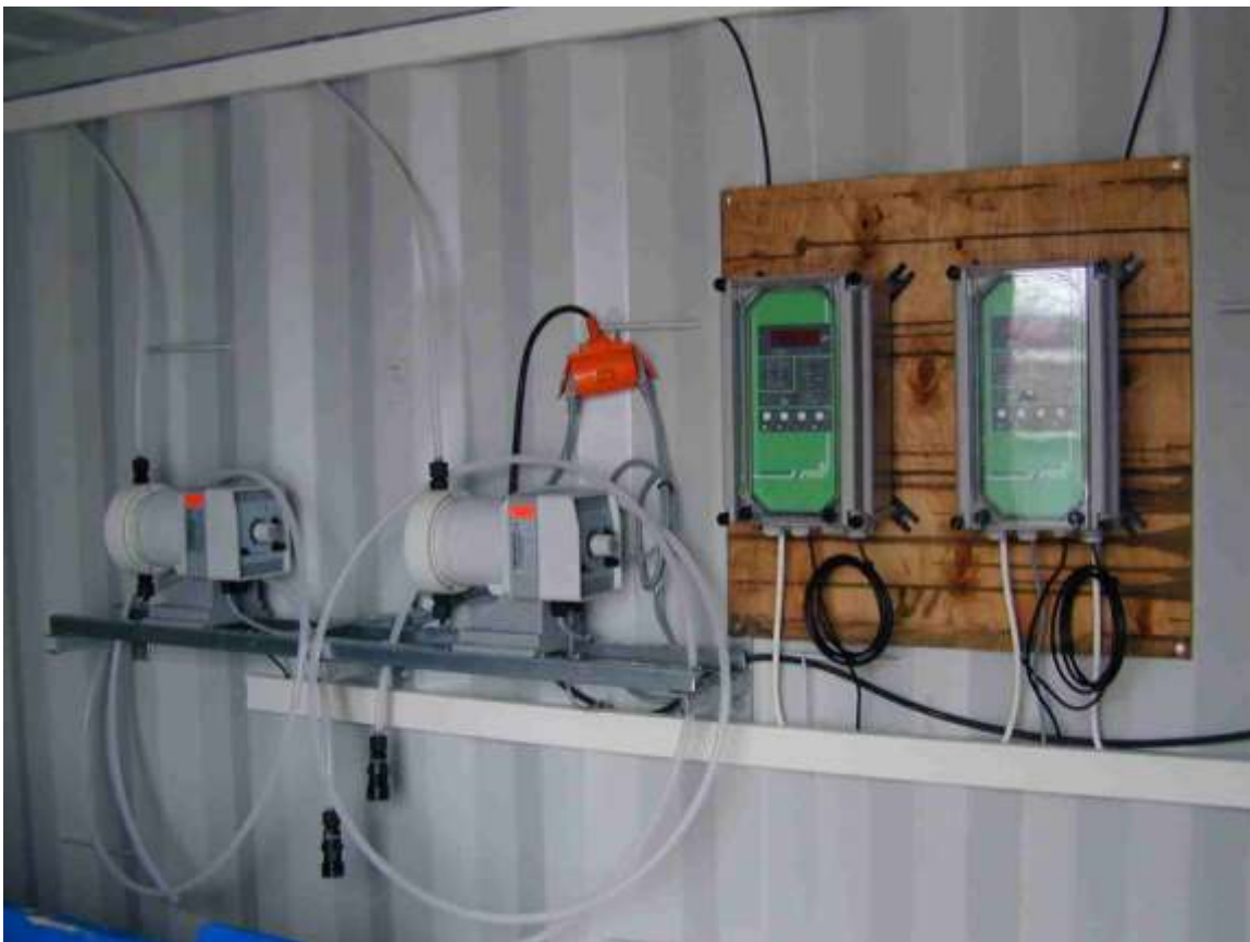
Figur 13. pH-loggere og pumper for styring av henholdsvis grov- og finjustering av pH med mineralysyre før utslipp til Isielva.
