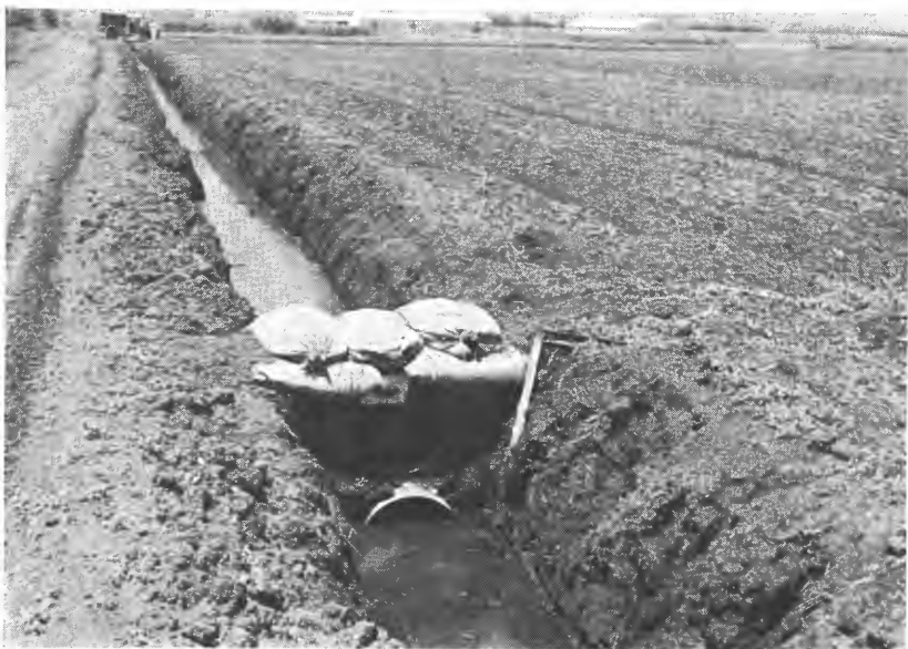
Fra Hula myrene. «Fordelingsgrøft» med klopp av sandsekker. På bildet sees to gjennomløp som begge benyttes ved regulering av vannhøyden i torpedogrøftene. Fot. Aa. L.
