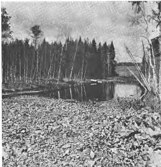
Fig. 1. Setning av vegfylling på myr.
