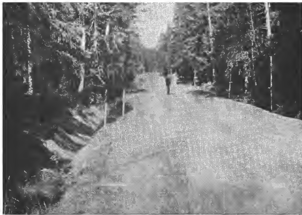
Fig. 6. Gyllermyra, ferdig utbedret veg.
