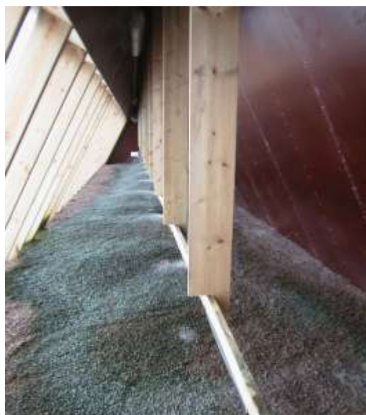
Figur 3. Eksempel på rislefilter/forfilter til et filterbedanlegg. Foto: Jens Christian Køhler.
