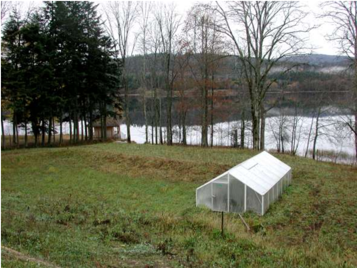
Figur 1. Filterbedanlegget på Bogstad gård, forfilter inni drivhuset og hovedfilteret til venstre for drivhuset. Foto: Bioforsk arkiv.
