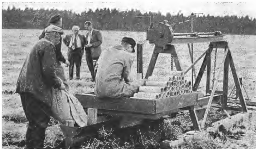
Fig. 5. Myrgrøfteren. Myrgrøfteren spalter myrslaget og rørene føres ned og blir en sammenhengende rørstreng i bunnen av spalten. Bakerst i maskinen kan rørene kontrolleres og forskjellig dekke fylles på. Kutterflis kan f. eks. brukes.
