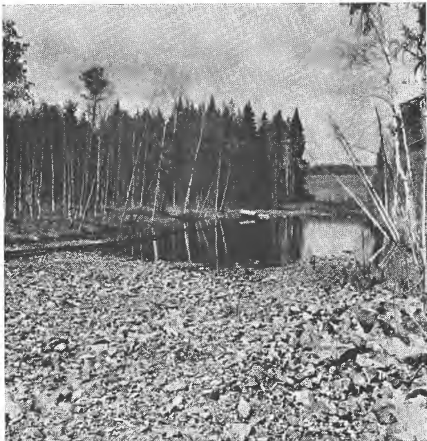
Fig. 1. Setning av vegfylling på myr.
