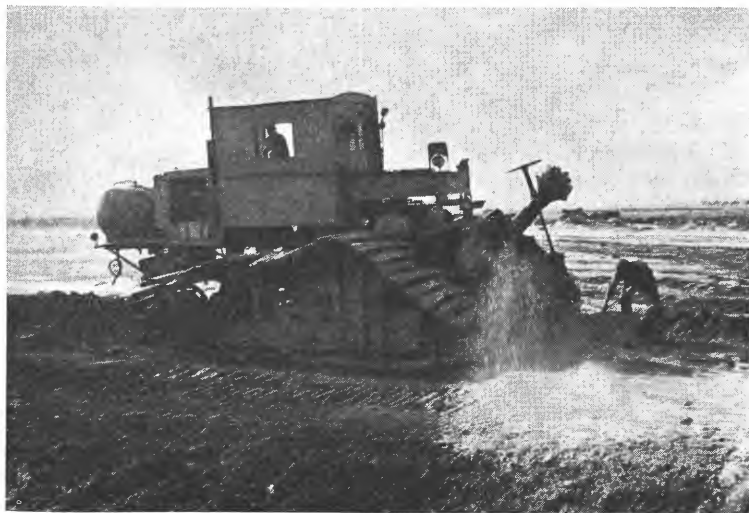
Fig. 4: Dr. Rathjens sanddekkingsmaskin i arbeid (Emsland 1962).
