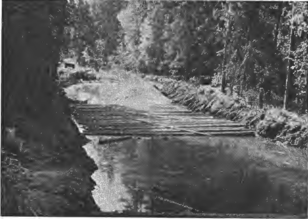
Fig. 5. Gyllermyra, utlegging av sagflis.
