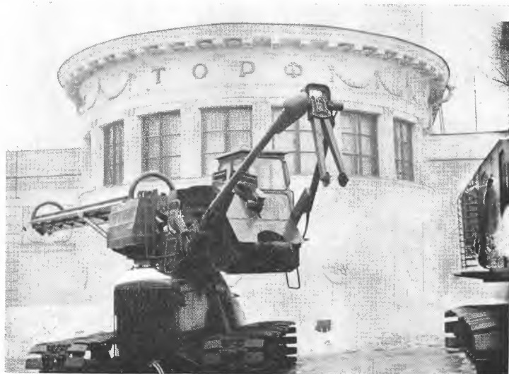
Torvpaviljongen ved den permanente landbruks- og industriutstillingen i Moskva. I forgrunnen ses en spesialbygget maskin som kvister og barker trærne, samt kapper og legger tømmeret pent fra seg for transport. M. a. o., skogen felles, kvistes, bakes og kappes helt maskinelt. Etterpå følger kjempegrubber som renser jorden for stubber og røtter. Fot. Aa. L.
