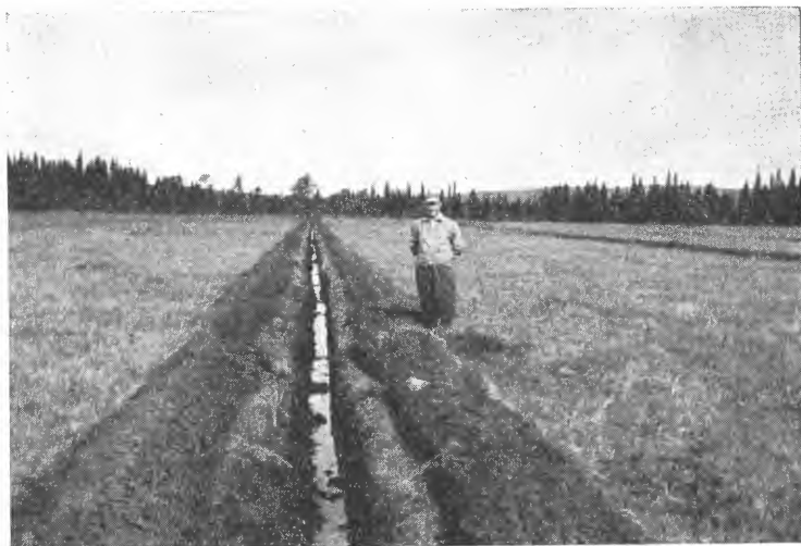
Fig. 2. Grøft opptatt med Vikeidploegen på Hjellummyra i Furnes almenning, Hedmark.
