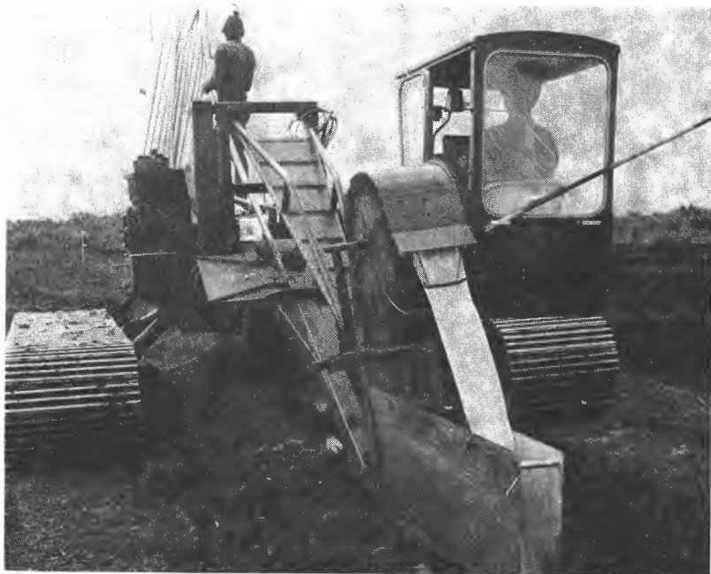
Fig. 3. Drainmaster, rørene dekkes med filterstrimmel.
