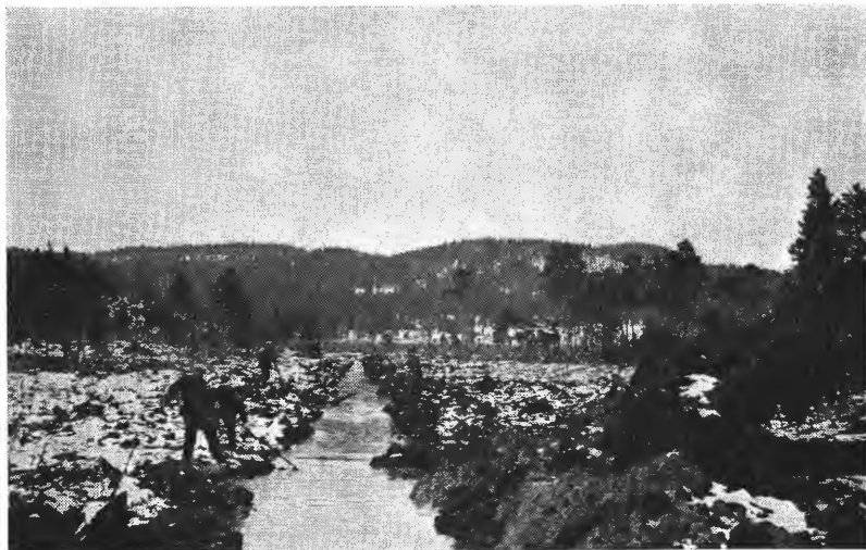
Kanal sprengt med grøftedynamitt. Løksmyra i Flå, Sør-Trøndelag.
