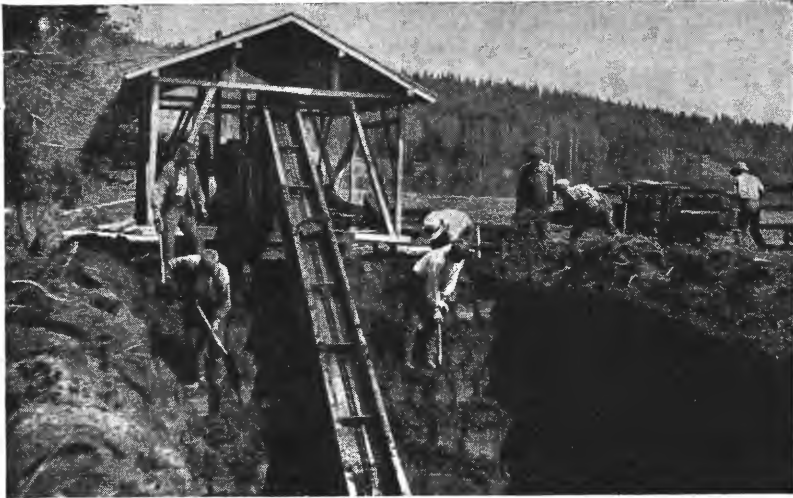
Brenntorvmaskin på Torvskolen. Torven kjøres ut til tørkefeltet på traller.
