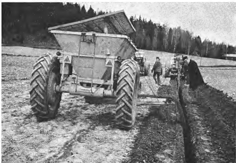
Fig. 1. Grus påføres med spesialvogn.
