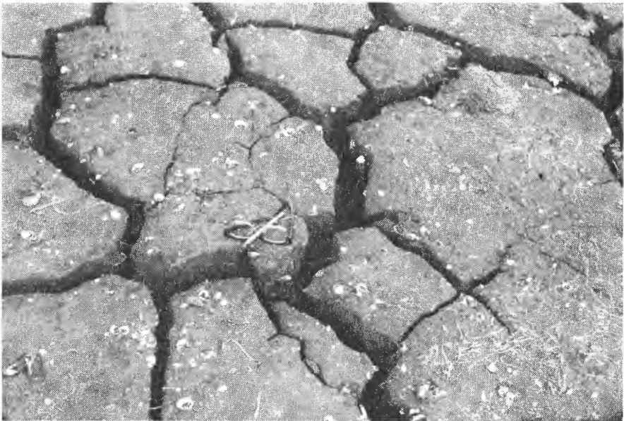
Krympesprekker i overflata, etter uttapping, men før drenering.
