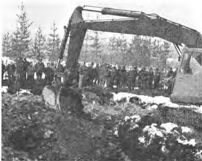
Omgravning av grunn myr på siltjord. 30—40 cm silt legges på toppen.
