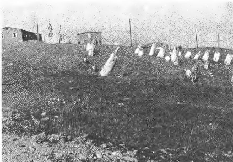
Fig. 7. Stolpene er forskjøvet så de står på skrå på grunn av sig i jordmassen (solifluksjon). 25. VII. 78.
