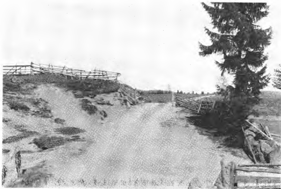
Figur 3. Skjæring i dyp forvittringsjord av larvikitt. Omsland i Kjose, Brunlanes.
