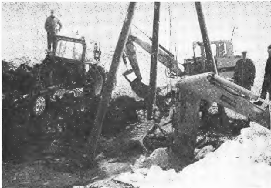
Smøla, Januar 1979. Gravemaskinen har gått til bunns og utstyr for redningsaksjon er på plass. Foto R. U.
