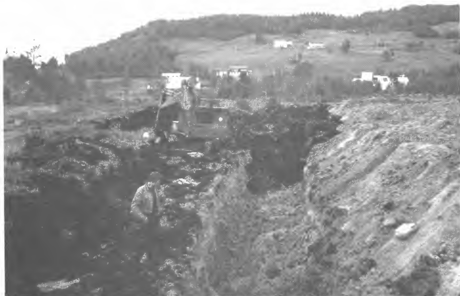
Djuparbeiding – mineraljord fra undergrunnen legges på toppen. Stormyra, Bleikvassli, Hemnes kommune.
