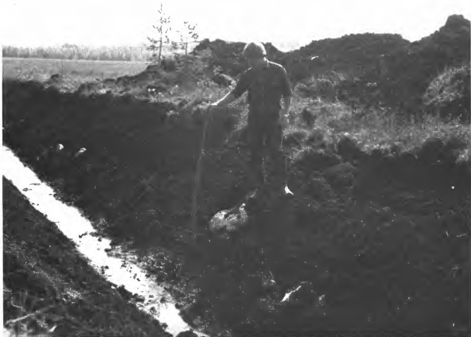
Kanal på myr i Pasvikdalen, Sør-Varanger kommune. Steinene i torvlaget er løftet opp av telen. Foto: P. Hornburg.
