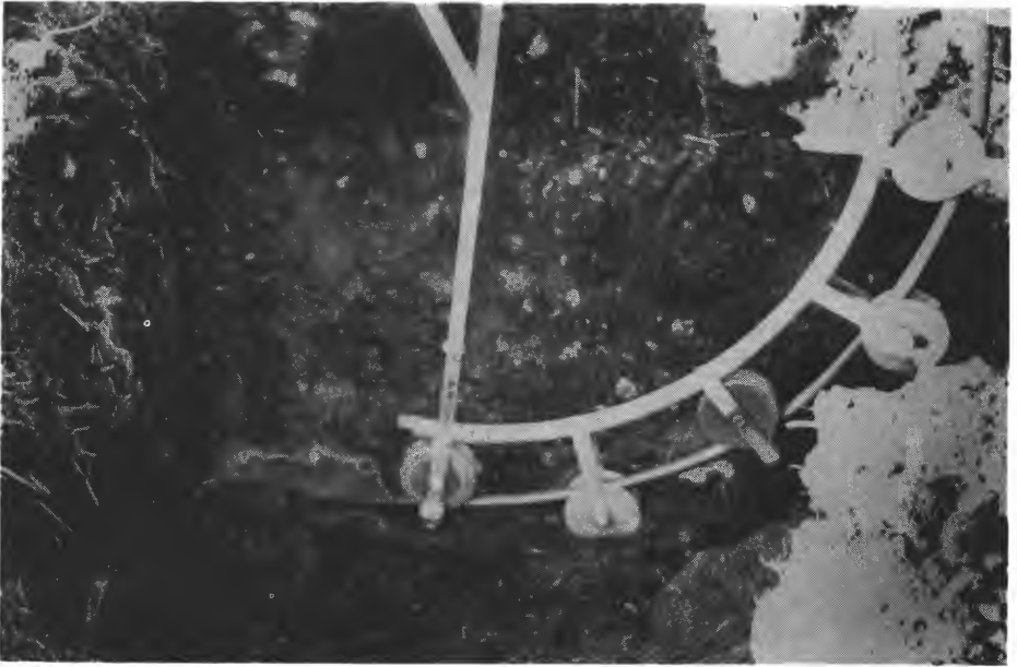
Spyling fra et grøftekryss.
