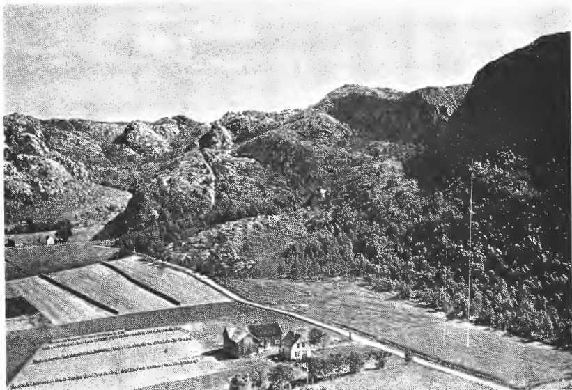
Bjørndalen 1962. I forgrunnen «Heimstad» med bauta over brukseier Torkilsen ved inngangen til bruket. Bygningene er reist av selskapet.
