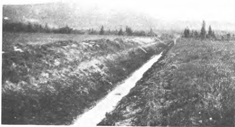
Kanaliseringsarbeid på Tramyr i Overhalla. Feltet innkjøpt i 1927. «Ny Jord» 1930.
