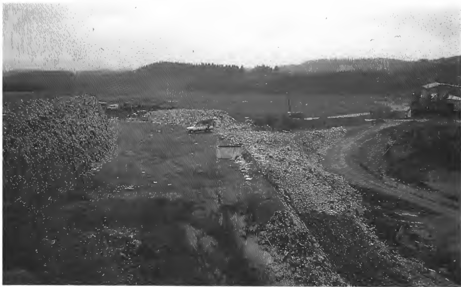
Et knausterreng nær Stend jordbruksskule er sprengt ned ved pukkproduksjon (t.h.). Deretter fylles arealet opp med avfall fra Bergen (t.v.). Dette skal dekkes med torv. Bak: Engareal på avslutta fylling.
