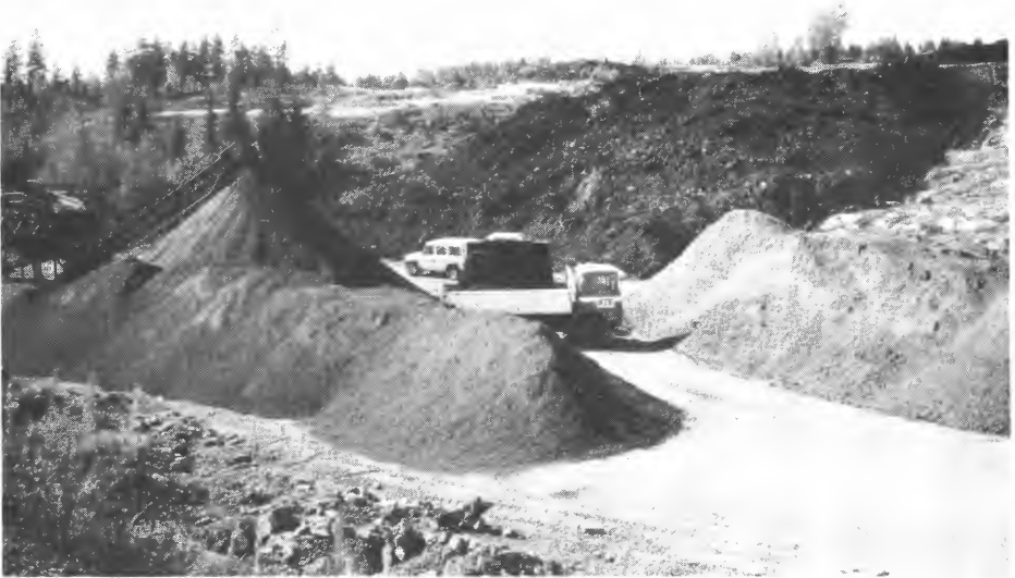
Bilde 2 Mekanisert blanding av steinmjøl og torv (30 vol.pst). Ved sikting fjernes stein og røtter (haug t.h.).
