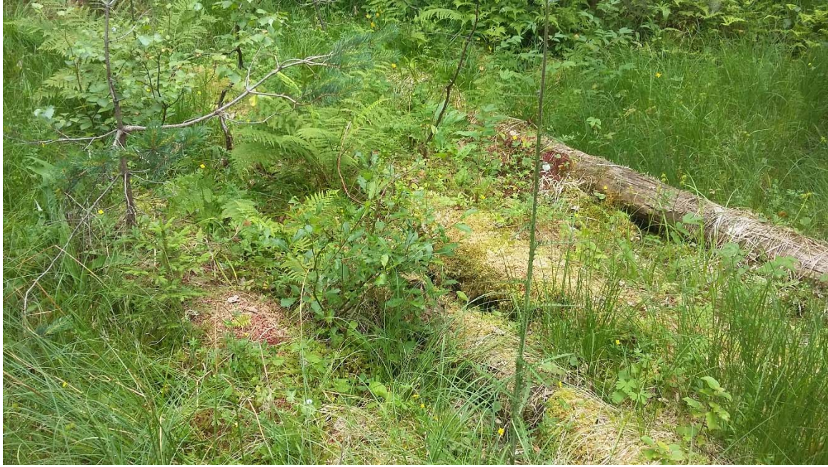
Figur 8. Et stykke oppe i lia går seterveien over et fuktig myrparti og her er det rester etter «kavlær» dvs stokker lagt ut for å øke bæreevnen på myra for transport. Foto ES 24.07.2017.
