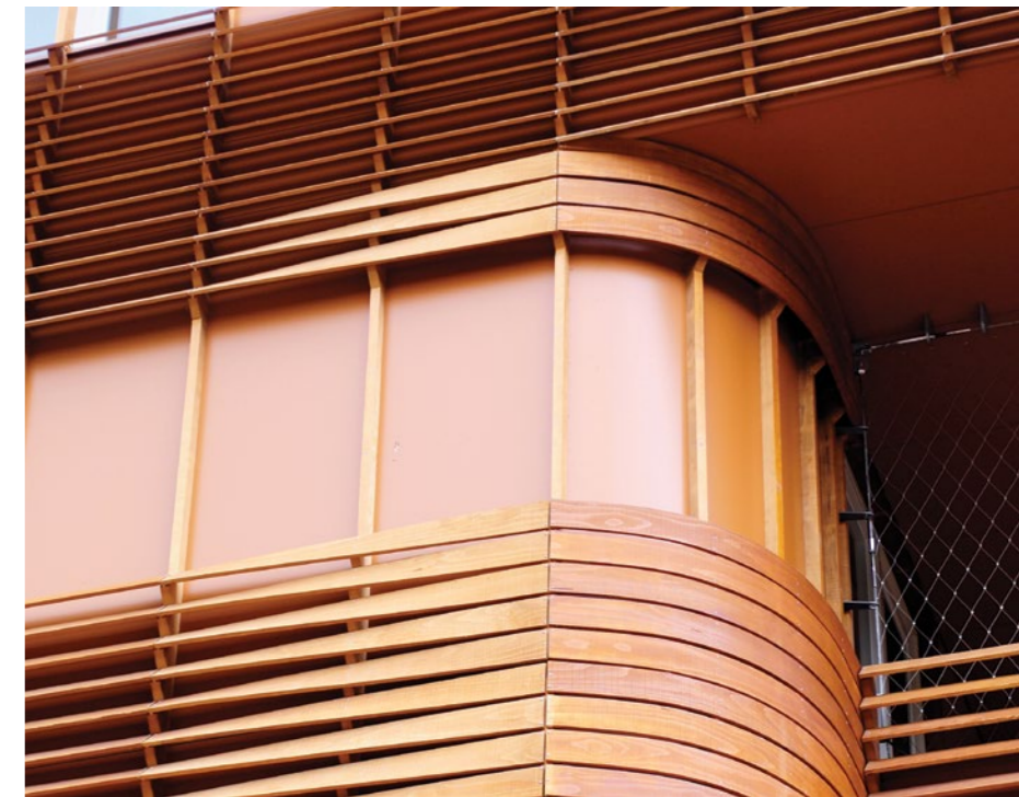
Buktende Accoya trekledning, Nederland. Foto: Accsys Technologies
