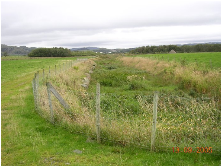
Bilde 5: Skrudlanddammen sett fra utløpet. God vegetasjonsdekning. Foto: Atle Hauge
