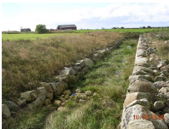
Bilde 7 og 8: Friestaddammen, første vegetasjonsfilter og andre vegetasjonsfilter. Første vegetasjonsfilter har beitetråkk ned i dammen på venstre side. Foto: Atle Hauge
