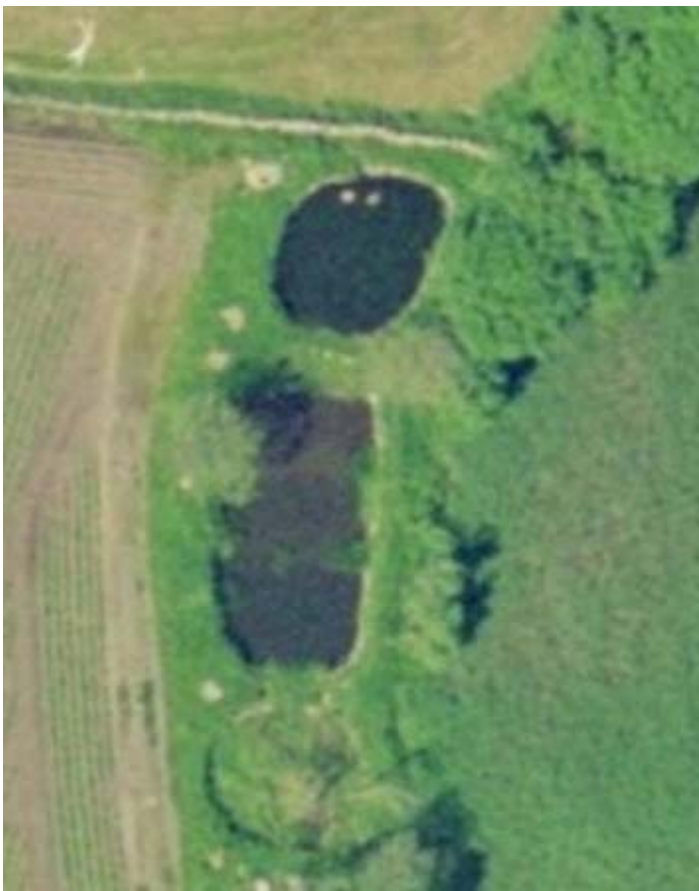
Bilde 9: Høylanddammen sett fra luften. Tredje kammer er ute av funksjon.
