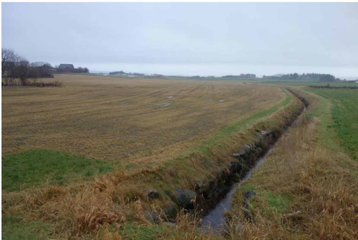
Figur 13. Kanal fra Søylandsvatnet. Eksempel på kanal med steinsatte og bratte kanter, noe som er typisk for mange kanaler i området. Kanalene har lange og relativt rette løpsstrekninger. Det er ingen trær eller busker langs kanten. Foto: A-G. B. Blankenberg.
