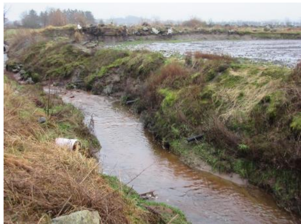
Kanal får tilførsler av vann fra overflaten og mange dreneringsrør. Foto: A-G. B. Blankenberg (venstre) og E. Skarbøvik (høyre).
