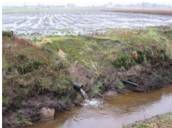
Kanterosjon, kanten raser ut flere steder langs kanalen. Foto: A-G. B. Blankenberg (venstre) og E. Skarbøvik (høyre)
