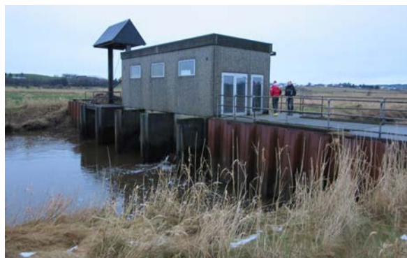
Pumpestasjon ved Skas-Heigre kanalen. Pumpeanlegget i kanalen sørger for at vannet pumpes ut, og er derfor vesentlig for at oppstrøms areal kan brukes til matproduksjon. Foto: A-G. B. Blankenberg (venstre) og E. Skarbøvik (høyre).
