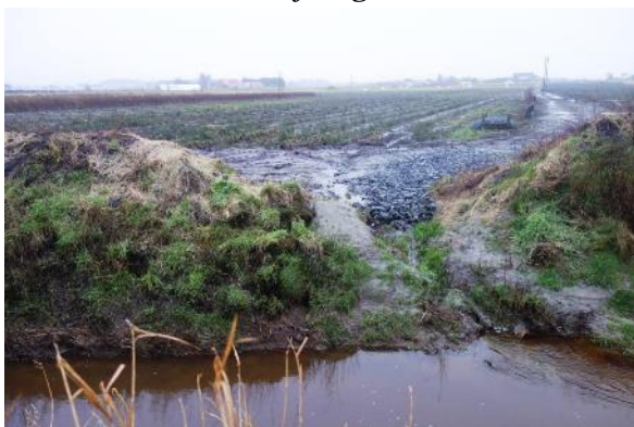
Erosjon fra jordet er forsøkt redusert med en steinfylling. Foto: A-G. B. Blankenberg.
