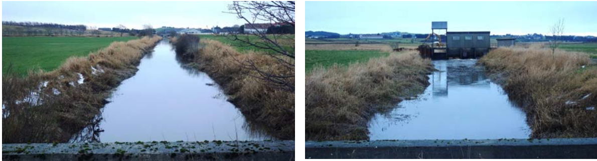
Kanal og landskap sett i begge retninger fra bro som går over kanalen langs Skasmyrvegen over kanalen. Til venstre sees hvor vannet pumpes nedover kanalen mot utløpet i Figgjoelva og til høyre sees oppover mot pumpestasjonen. Foto: A-G. B. Blankenberg.
