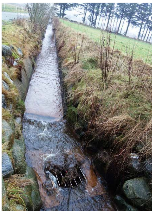
Venstre bilde viser en del av kanalen som er støpt i betong, og deler av vannet går ned gjennom en rist og renner videre under den steinsatte kanalen i bildet til høyre. Bilde til høyre viser at det langs deler av kanalen står en rekke av bartrær. Foto: A-G B. Blankenberg.
