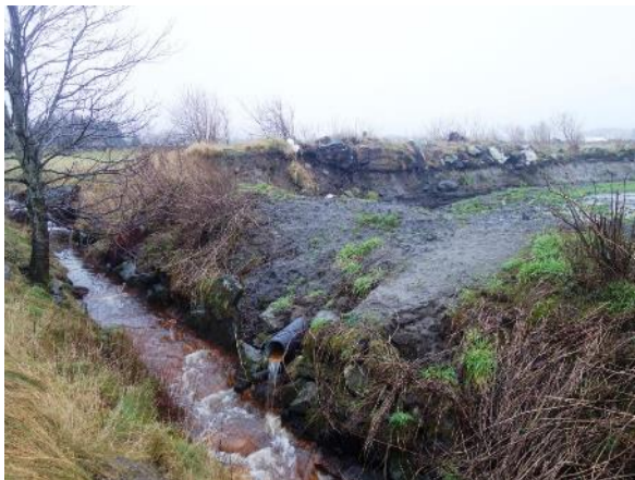
Kanal får tilførsler av vann fra overflaten og mange dreneringsrør. Foto: A-G. B. Blankenberg (venstre) og E. Skarbøvik (høyre).
