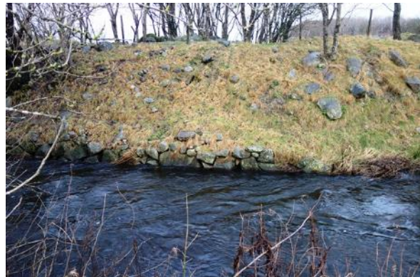
Deler av elva er steinsatt. Dette gir høyere vannhastighet i elva enn om det hadde fantes naturlige meandersvinger, bakevjer o.l. som kunne ha bremset vannet. Foto: E. Skarbøvik (venstre), A-G. B. Blankenberg (høyre).
