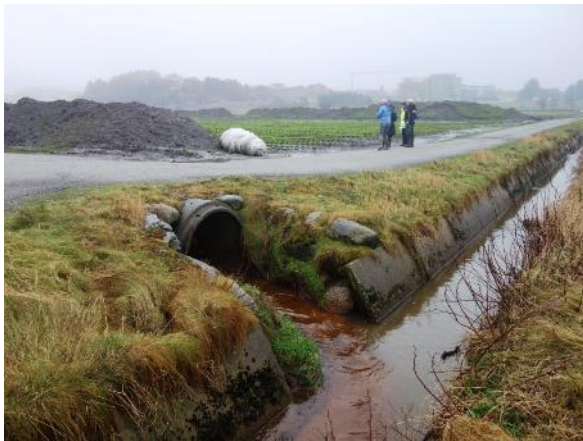
Kanalen har mange tilførselskilder, her vises et sideløp med rødbrunt vann som renner inn i betongkanal. Foto: A-G. B. Blankenberg (venstre) og E. Skarbøvik (høyre).
