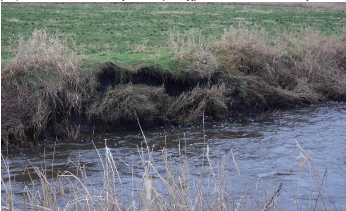
Kanterosjon på arealer hvor det kjøres og dyrkes nesten helt ut til relativt bratte kanter. Deler av kanten løsner og sklir ut i vannet. Bildet er tatt mellom pumpestasjon og bro langs Skasmyrvegen over kanalen. Foto: A-G. B. Blankenberg.
