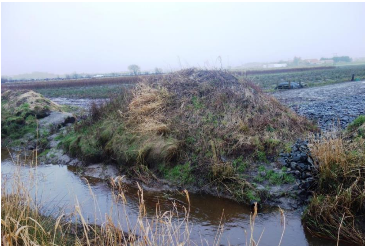
Overflatevann fra jorde graver seg kanaler ut i kanalløpet. Til høyre i bildet er erosjon forsøksvis redusert med en steinfylling. Foto: A-G. B. Blankenberg.
