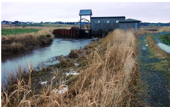
Pumpestasjon ved Skas-Heigre kanalen. Pumpeanlegget i kanalen sørger for at vannet pumpes ut, og er derfor vesentlig for at oppstrøms areal kan brukes til matproduksjon. Foto: A-G. B. Blankenberg (venstre) og E. Skarbøvik (høyre).
