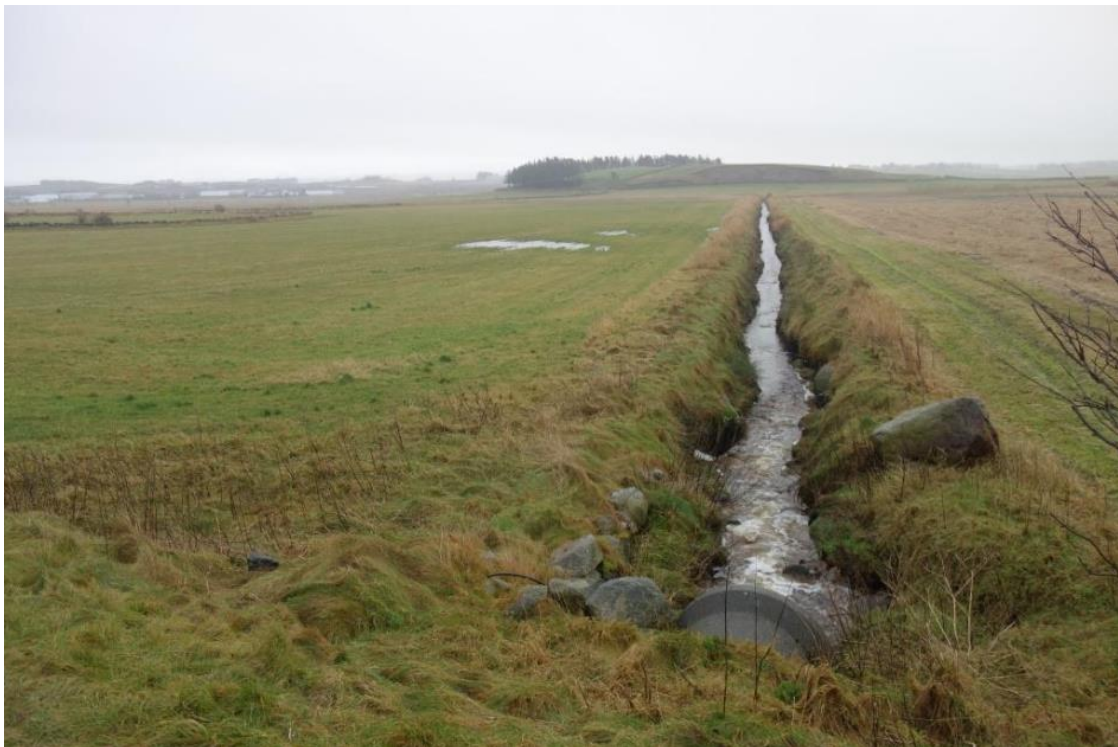
Figur 12. Øygardsfitjane-kanalen. Kanalen har delvis steinsatte kanter, noe som er typisk for mange kanaler i regionen. Kanalene er lange og rette med relativt bratte kanter. Det er ingen trær eller busker langs kanten. Foto: A-G. B. Blankenberg.
