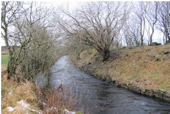
Deler av elva er steinsatt. Dette gir høyere vannhastighet i elva enn om det hadde fantes naturlige meandersvinger, bakevjer o.l. som kunne ha bremset vannet. Foto: E. Skarbøvik (venstre), A-G. B. Blankenberg (høyre).
