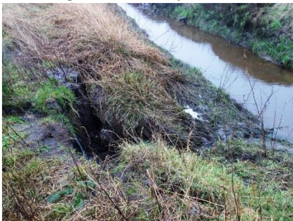
Kanterosjon, kanten raser ut flere steder langs kanalen. Foto: A-G. B. Blankenberg (venstre) og E. Skarbøvik (høyre)
