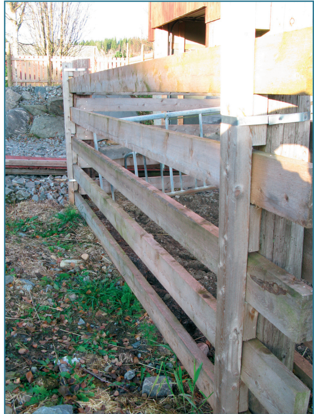
Fig. 6. Solid inngjerding av tre. 140 cm høyt. Stolpene er satt ca 1 m ned i bakken. Foto: Lise Aanensen, Bioforsk Nord Tjøtta.
