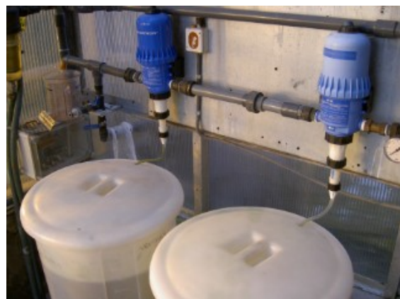
Vanningsautomat med to dosatroner, som pumper opp gjødsel fra hver sin stamp med stamopløsning.
