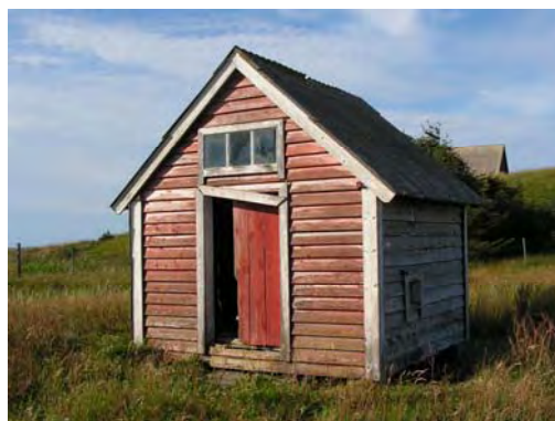
Sommerfjøs med plass til et par kyr. Askvoll i Sogn og Fjordane.
