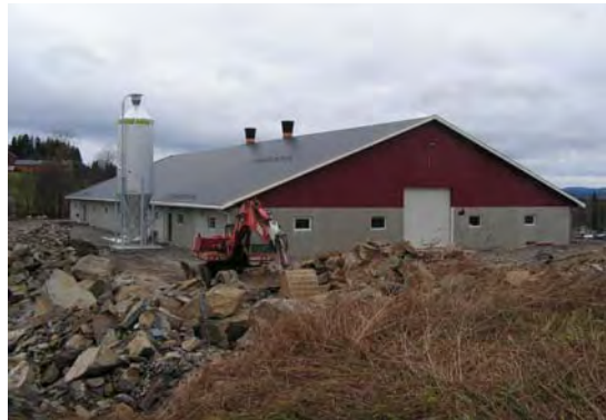
Storfjøs under bygging. Vestre Toten, Oppland.
