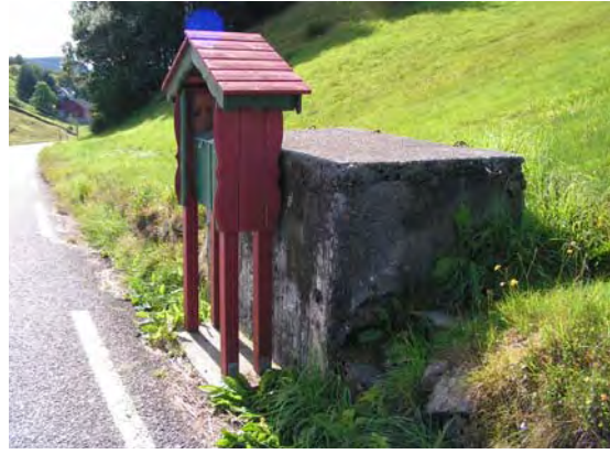
Betongrampe i Radøy, Hordaland.
