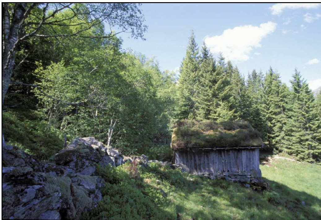
Bilde 43: Gamle bygninger som ikke lenger har noen funksjon ligger mange steder bare som forfalne minner om tidligere tiders driftsformer. Her et vårflor (vårfljos) fra Volda kommune, Møre og Romsdal.
