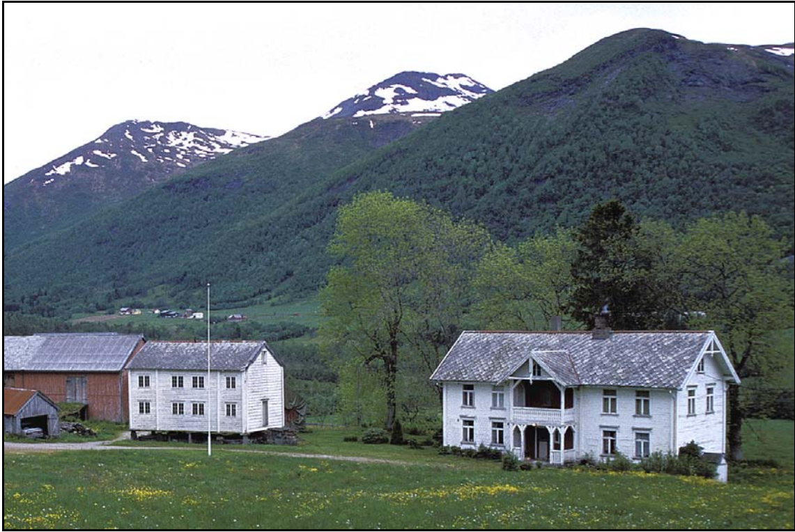
Bilde 26: En type bygninger som på Vestlandet har et skille omtrent i Romsdalen er de avlange bustadshusa, lånene, som er en typisk trøndersk byggeskikk. (Gjemnes kommune, Møre og Romsdal).
