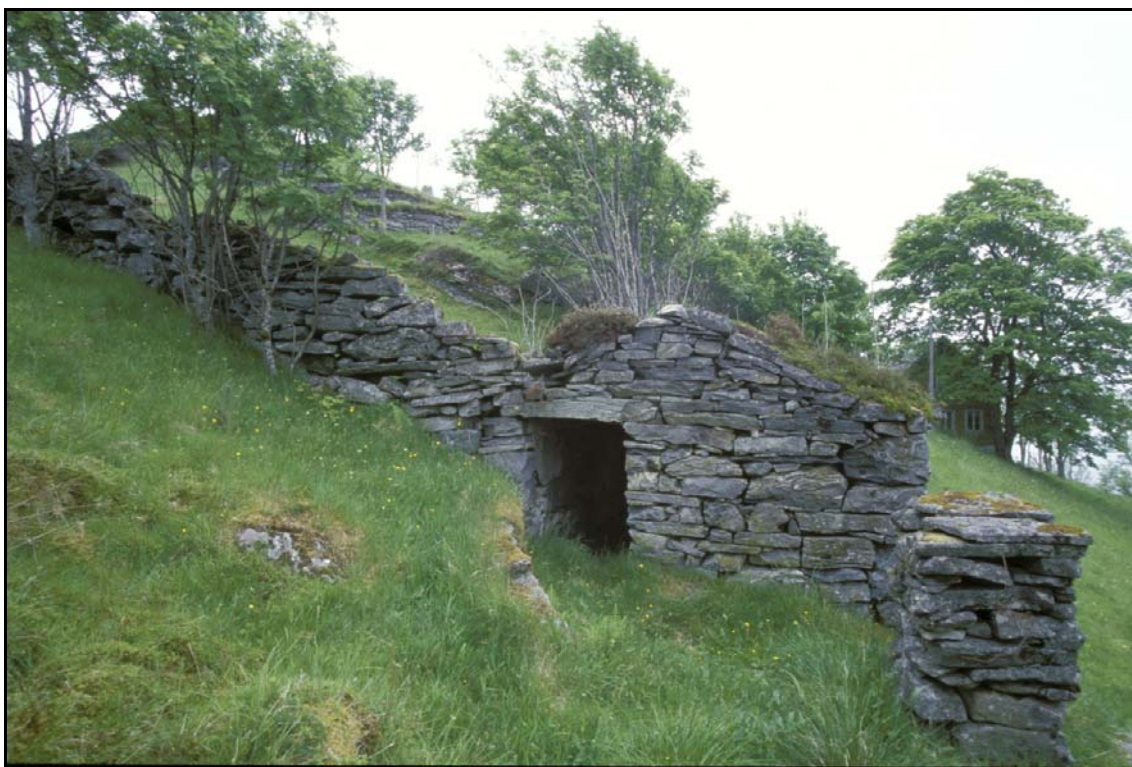
Bilde 6: De gamle bøgardene bygd i stein er et særtrekk for den mer vegetasjonsløse kystregionen. (Selje kommune, Sogn og Fjordane).
