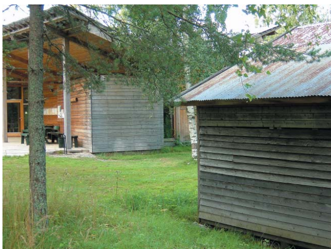
Ubehandlet grankledning på Naturinformasjonssenteret ved Fetsund Lenser. Foto: Per Otto Flæte
