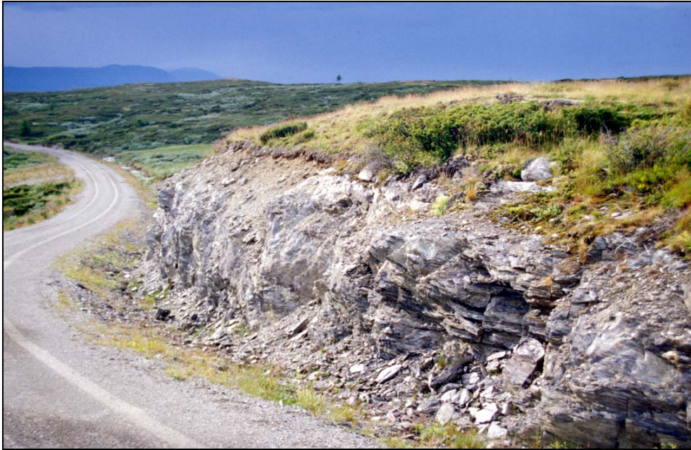
Bilde 2. Fyllitt i vegskjæring ved Brattåsen (Foto M. Angeloff)
