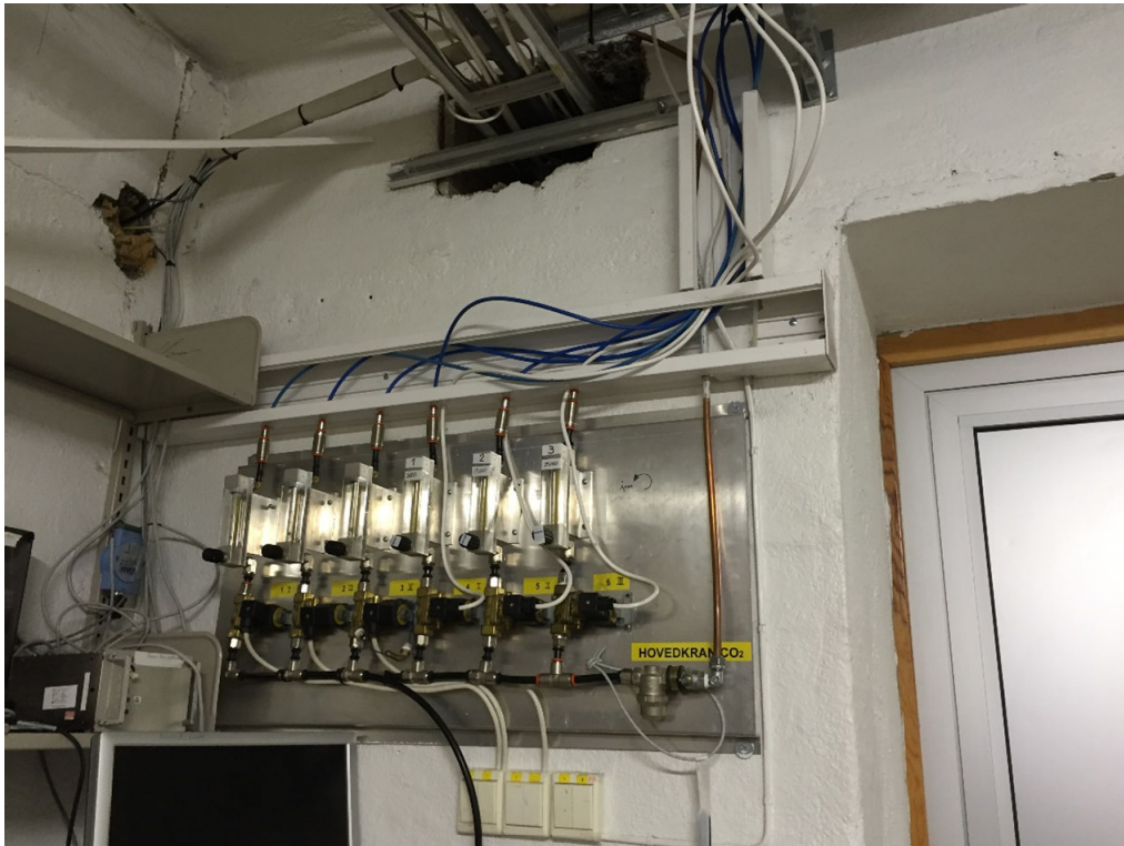
Bilde 4. Styresystem for CO 2 inntak til forsøkslager
