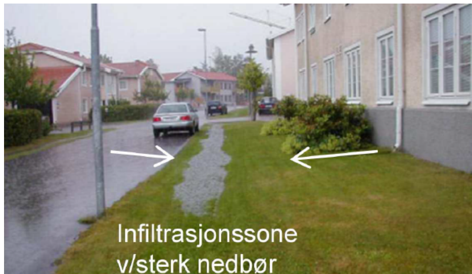
Figur 1. Eksempler på infiltrasjonsområder i plen for overvann i tettbebyggelse. Øverst ledes veivann ut i grasdekket infiltrasjonssone og nederst er det både veivann og takvann som ledes til infiltrasjonsområdet (Växsjö i Sverige, foto: Göran Lundgren). Kilde: Åstebøl m. fl. (2013).
