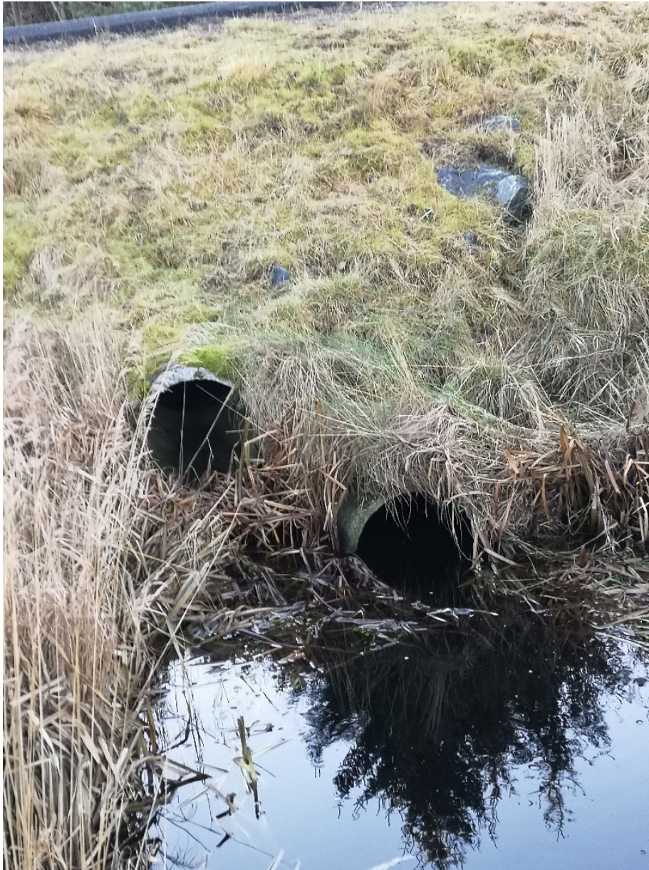
Bilde 6. Stikkrennene ovenfor dammen kan være et vandringshinder for fisk.
