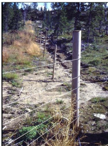
Figur 5. Rett, bred og flat trasé må tilstrebes (Foto: Ronald Bjøru, NIBIO/Norsk viltskadesenter).
