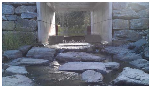
Figur 6. Terskel ved Hottran målestasjon i Trøndelag (Bilde: JOVA – programmet, NIBIO)
