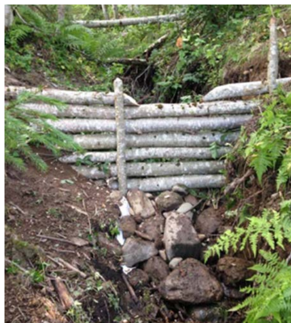
Figur 3. Stokkdam med fiberduk over nederste stokk som er steinsatt for å hindre erosjon (Bilde: B.C. Braskerud, Oslo kommune)
