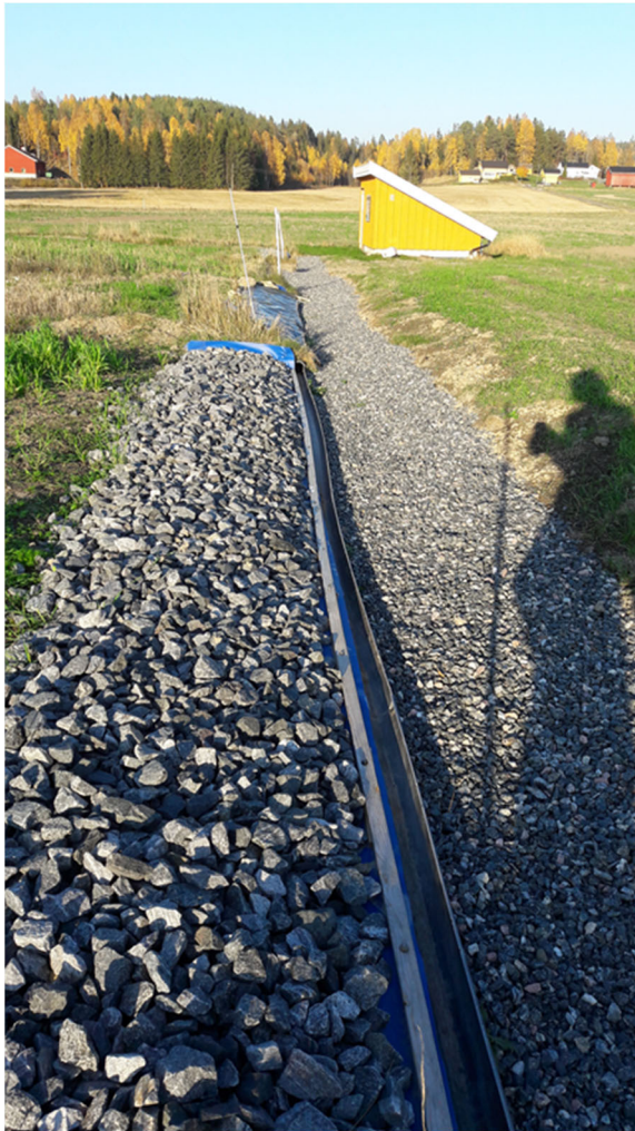
Figur 2.2. Ombygging av inntak for overflatevann. Grasbeltet erstattet med grus oppå tett duk (venstre) og 14. (rute 8) og 21. oktober 2018 (resten av rutene) ble det lagt pressenning over for å unngå regnvann direkte inn i intaket (høyre).
