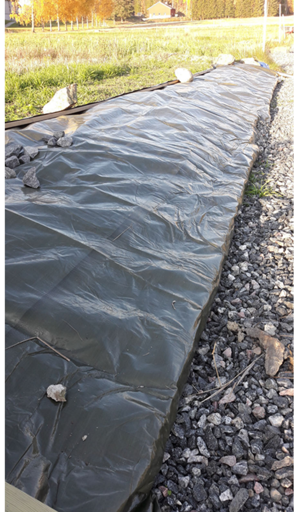
Figur 2.2. Ombygging av inntak for overflatevann. Grasbeltet erstattet med grus oppå tett duk (venstre) og 14. (rute 8) og 21. oktober 2018 (resten av rutene) ble det lagt pressenning over for å unngå regnvann direkte inn i intaket (høyre).
